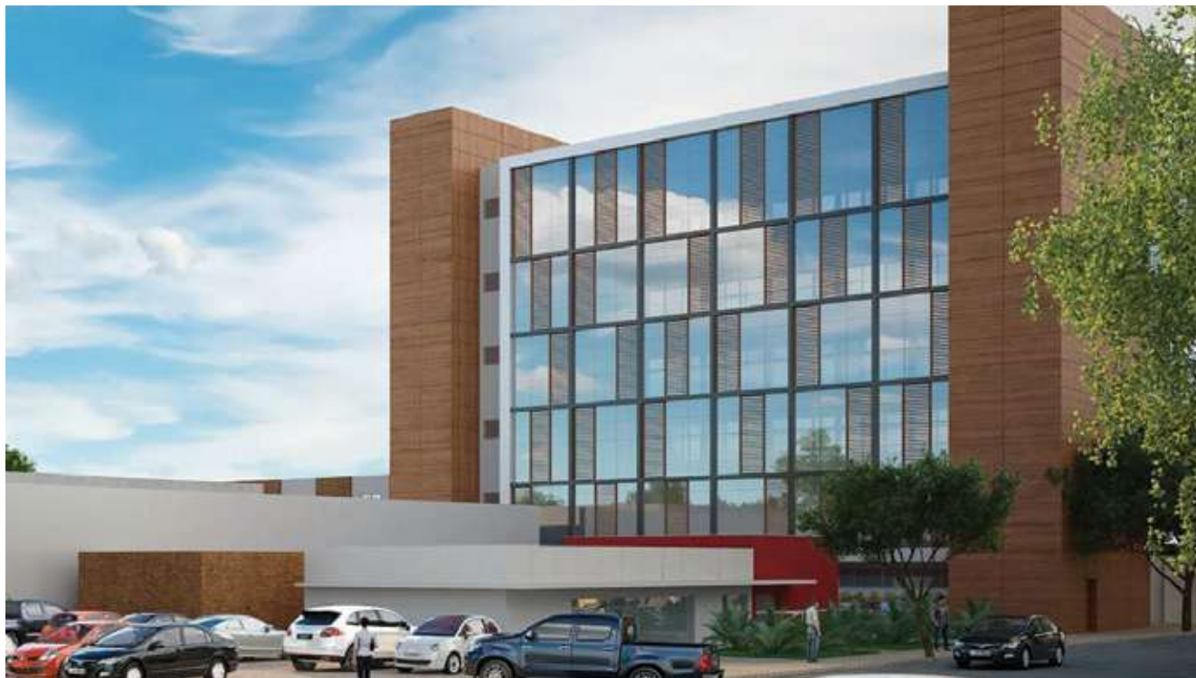
Grupo São Lucas anunciou, recentemente, a construção de uma nova torre no Hospital São Lucas
